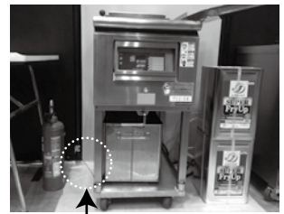
据え置き型フライヤーの壁面とのワイヤーを使用した固定例
